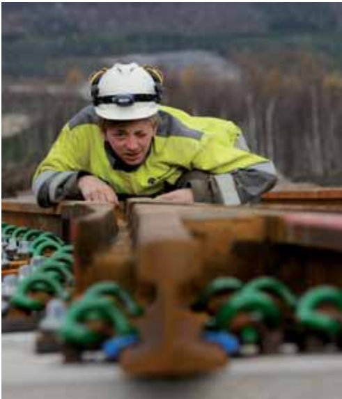
Figur 2.2: Nøyaktighet er viktig. Her sikter en lærling i banemontørfaget for å sikre at skjøtene blir så jevne som mulig. Foto: Øystein Grue, Jernbaneverket
